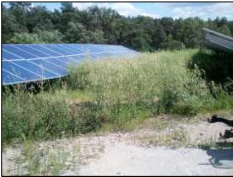
Bild 5: Zwei Mal pro Jahr wird in den Solarparks gemulcht, entsprechend hoch ist der Bewuchs
